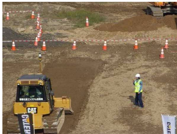
MCブルドーザによる 整地体験
